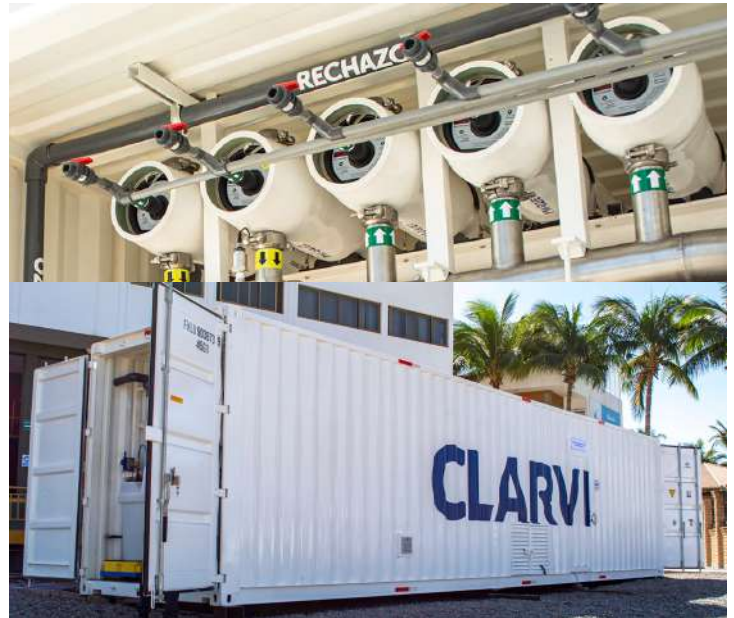
Sistema portátil para la reducción de sólidos disueltos en el agua de pozo a base de tecnología de osmosis inversa.
