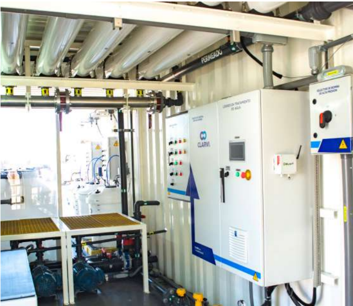
Sistema portátil para la reducción de sólidos disueltos en el agua de pozo a base de tecnología de osmosis inversa.
