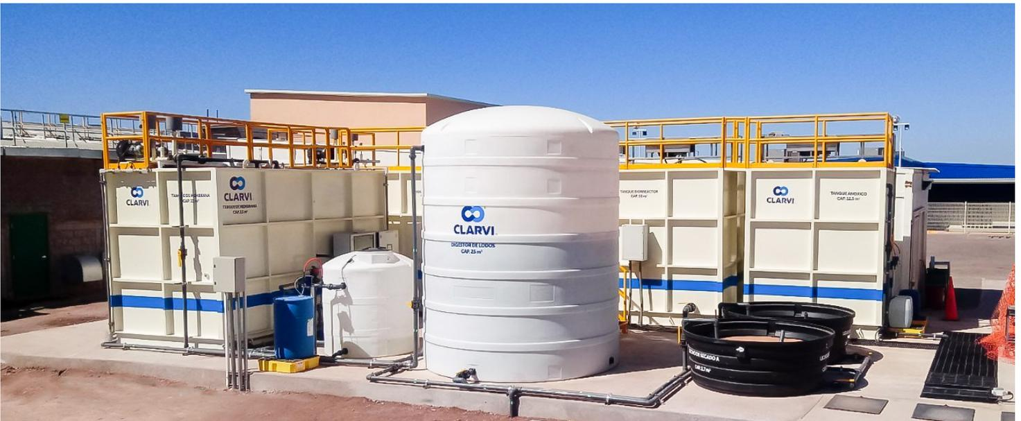
*Ilustración 1. Planta tratadora de aguas residuales con tecnología MBR para 150 metros cúbicos por día.*
